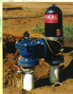
รูปที่ 29 กรองแบบแหวน
